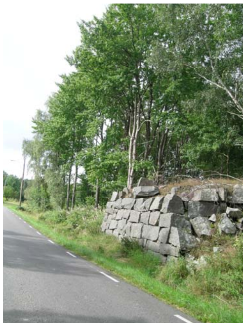
Den gamla lastbryggan är ett minne från stenindustrin vilken skyddas i detaljplanen.
